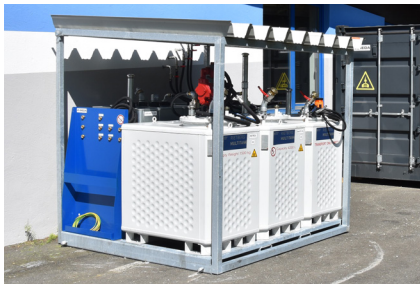
TPF5 mit Überdachung
