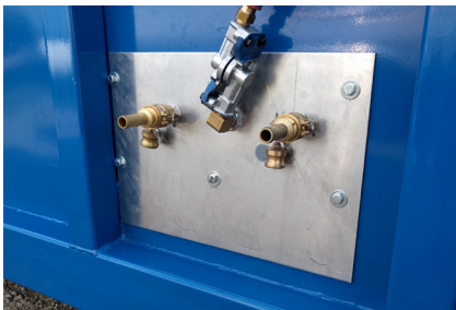
Vorinstallierte Schnellkupplungen für Tankleitungen
