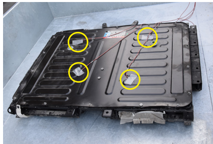
Temperaturüberwachung mit 4 Fühlern pro Behälter
